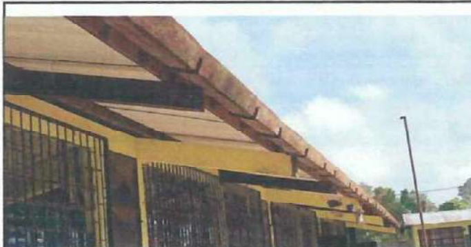
Foto 6: Canal en mal estado presentando perforaciones en su estructura y hace que filtre el agua.
