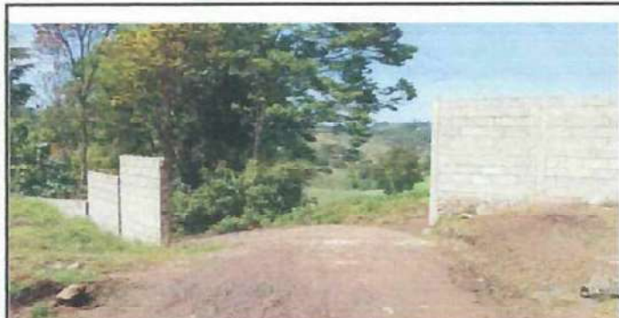
Foto 5: Falta de portón y fundicion para el reforzamiento de columnas que sostendra el porton de la entrada principal.
